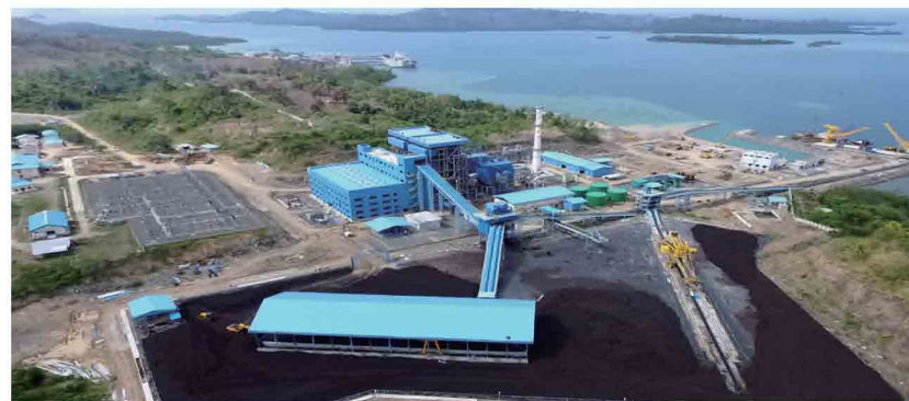
印度尼西亚Gorontalo燃煤电站，装机容量2×30兆瓦
