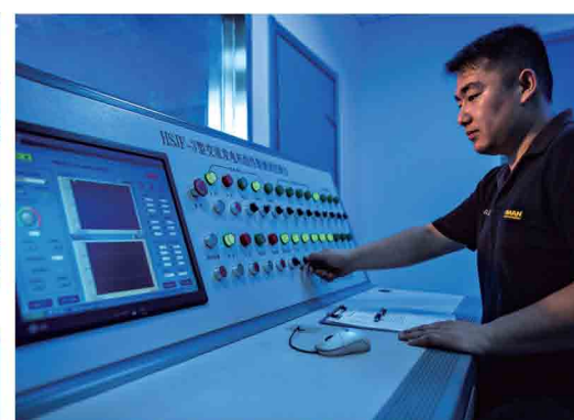
发电设备检测中心
