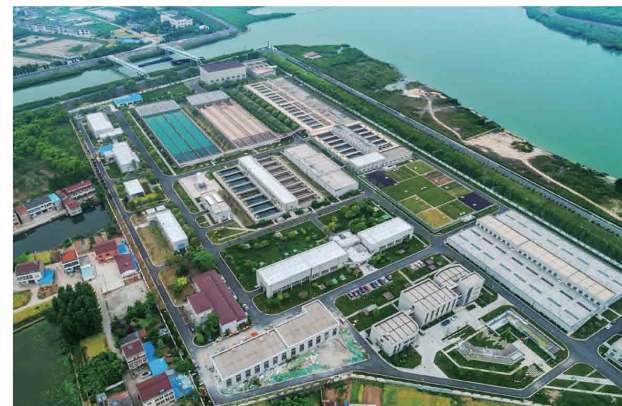
常州魏村水厂日供水处理规模70万吨，生活用水提高为“优质水”
