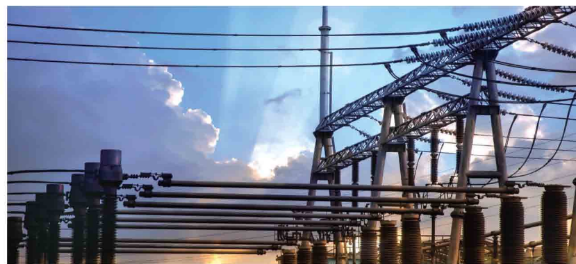
OMVG西非四国跨境输电线路工程，包括114.21公里双回双分裂线路和127.53公里单回双分裂线路
